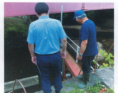
井堰についての要望を現地確認
